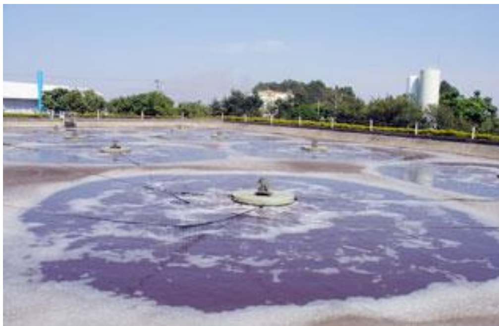
Figura 1 – Lagoa Aerada em funcionamento
